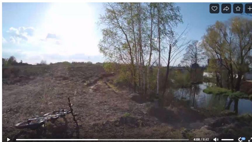
Рисунок 28. Дорога, состоящая из золошлаковых отходов МСЗ г.Москва, вдоль р.Чернавка, Люберецкий район, Московская область.
