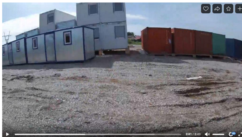
Рисунок 31. Отсыпка золошлаковыми отходами МСЗ площадки на территории промзоны д. Мотяково, Корневский форт 1.1, Люберецкий округ, Московская область.
