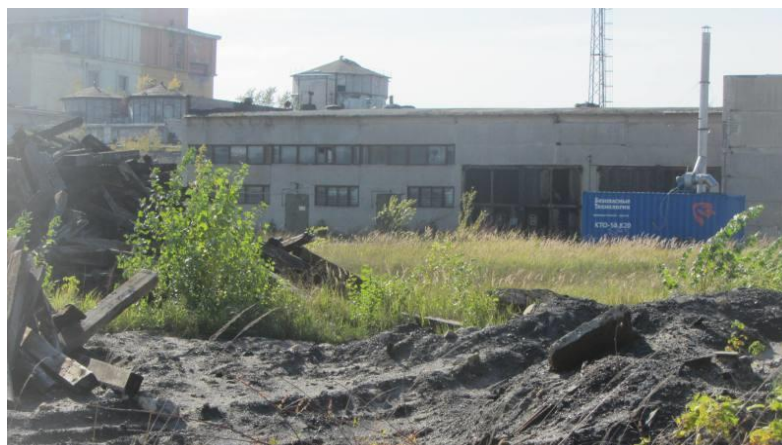
Рисунок 14. Инсинератор ООО «Экоуниверсал», находящийся на территории бывшей Игумновской ТЭЦ без разрешительных документов, г.Дзержинск. Фото Д. Левашова, ЭкоСПЭС.
