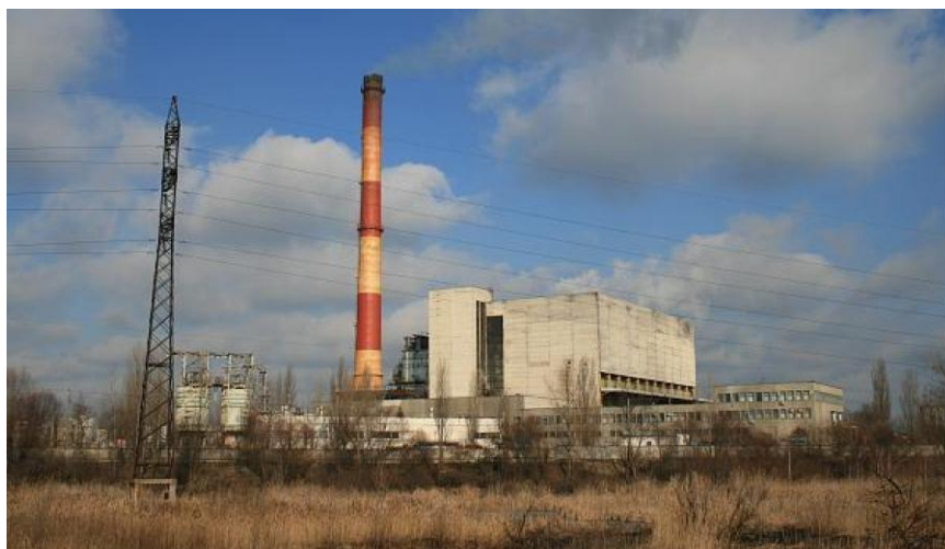
Рисунок 2. Мусоросжигательный завод в г.Пятигорск.
