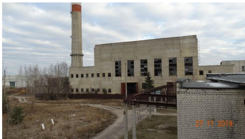
Рисунок 15. Бывшая ТЭЦ (мусороперегрузочная станция ООО «Экология-НН») бывшего завода «Заря», где осуществлялось нелегальное сжигание ТКО и медицинских отходов. Фото Д. Левашова, ЭкоСПЭС.
