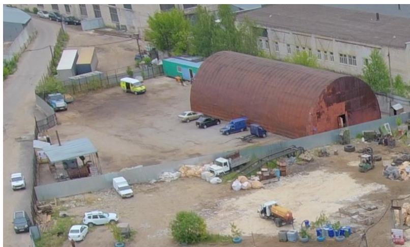
Рисунок 23. Установка сжигания медицинских отходов
