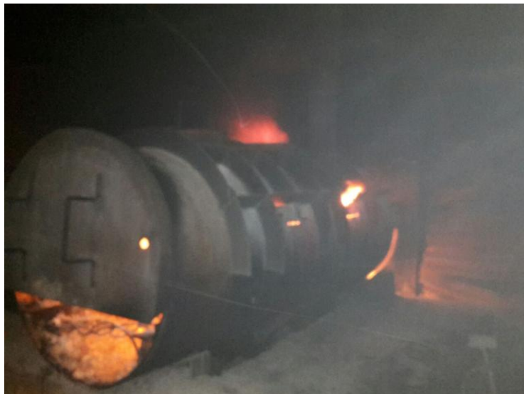
Рисунок 20. ООО «Тора», г.Волжский Волгоградская область. Печь сжигания коммунальных и медицинских отходов.
