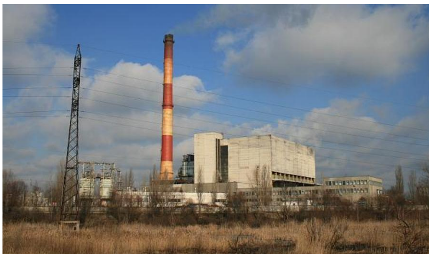
Рисунок 2. Мусоросжигательный завод в г.Пятигорск.
