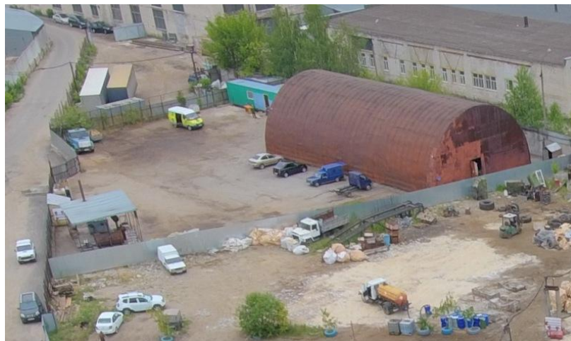
Рисунок 18. Установка сжигания медицинских отходов
