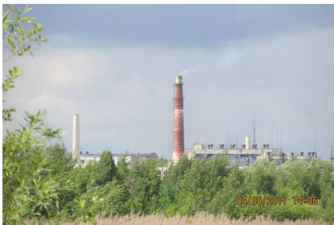
Рисунок 11. Нелегальное сжигание отходов производства на территории Индустриального парка «Ока-Полимер» (бывший завод «Капролактама») г.Дзержинск. Фото Д.Левашова, ЭкоСПЭС.
