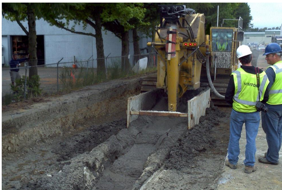
Рис. 10: Комбинированная прокладка траншеи с заливкой раствора
