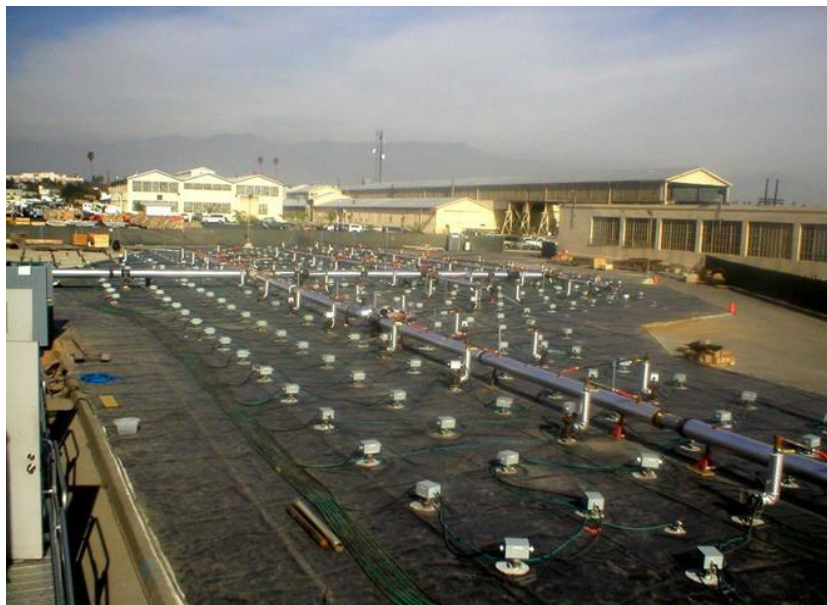
Рис. 12: Полномасштабная термическая десорбция без выемки материала на участке, загрязненном органическими веществами в США
