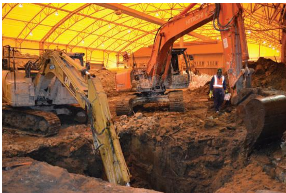
Рис. 8: Вид внутри защитного сооружения в ходе выемки грунта Источник: Australian Federal Government (2013)
